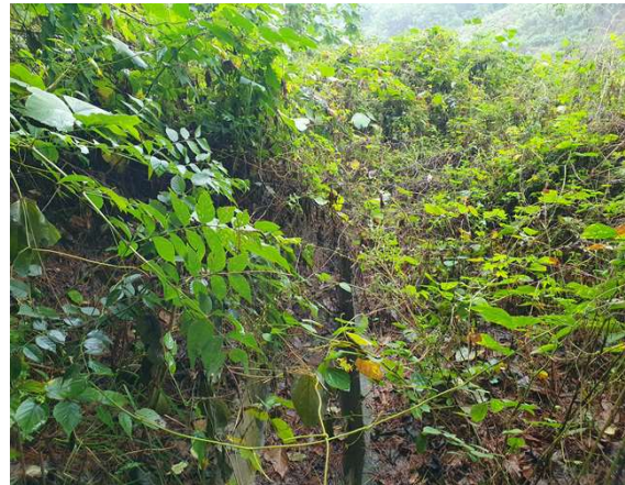
2소단 배수로 전경
