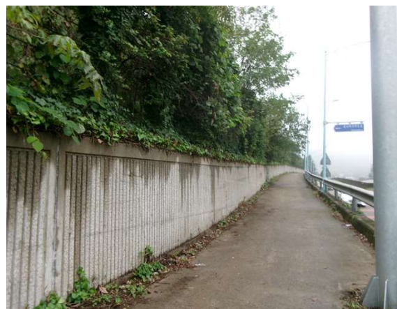
낙석방지울타리 및 하부 전경
