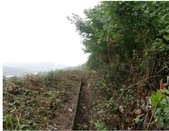
2소단 배수로 전경
