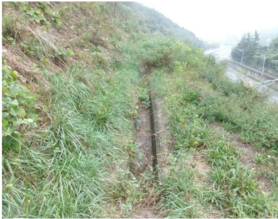
1소단 배수로 전경
