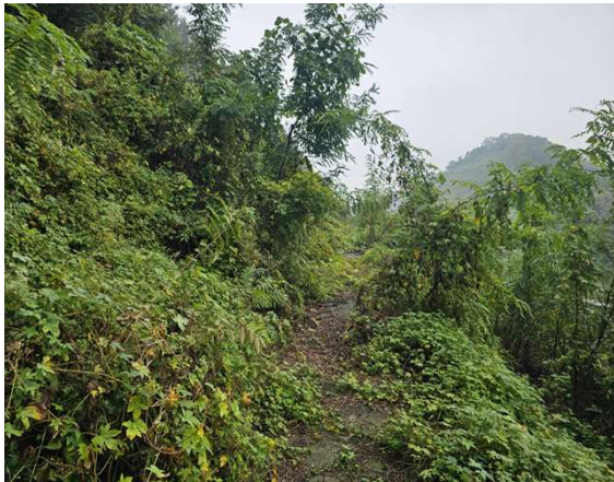
1소단 배수로 전경
