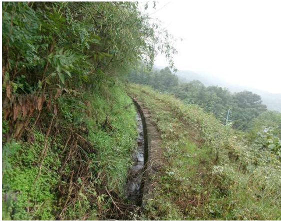
1소단 배수로 전경
