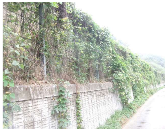
낙석방지울타리 및 하부 전경
