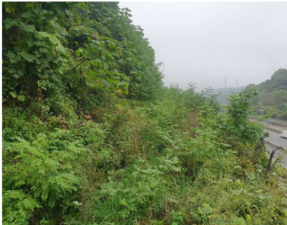
1소단 배수로 전경
