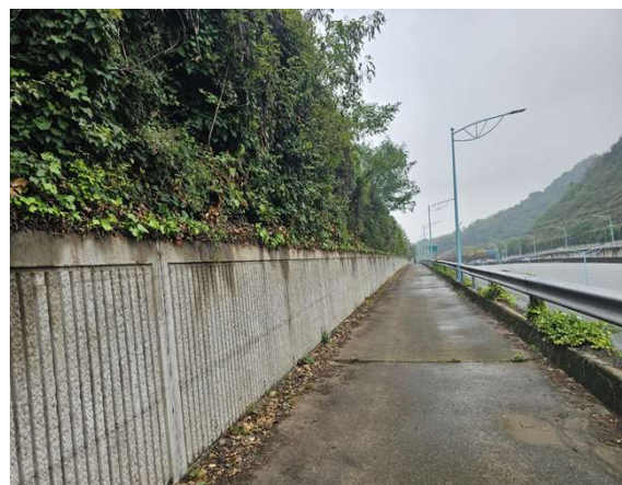
낙석방지울타리 및 하부 전경
