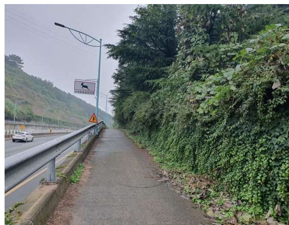
낙석방지울타리 및 하부 전경
