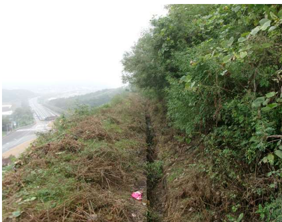
3소단 배수로 전경
