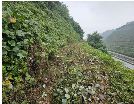
2소단 배수로 전경
